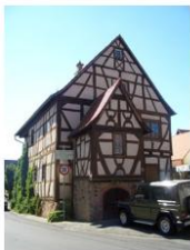
Altes Zollhaus in Otzberg-Lengfeld
